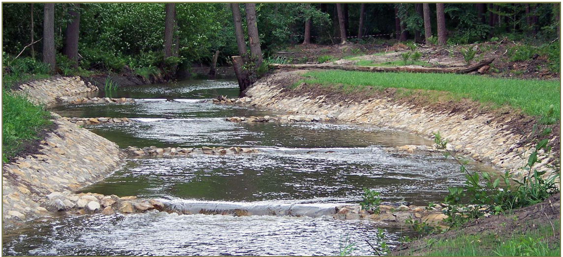
Herstelde Botterbeek met vistrappen
