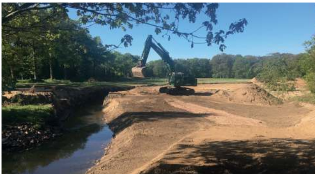
Aansluiting meander benedenstrooms Veddersbrug met drempel en in aanleg zijnde hoogwatergeul
